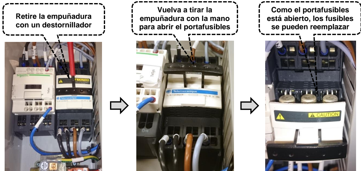
Figura 23: Reemplazo de los fusibles
